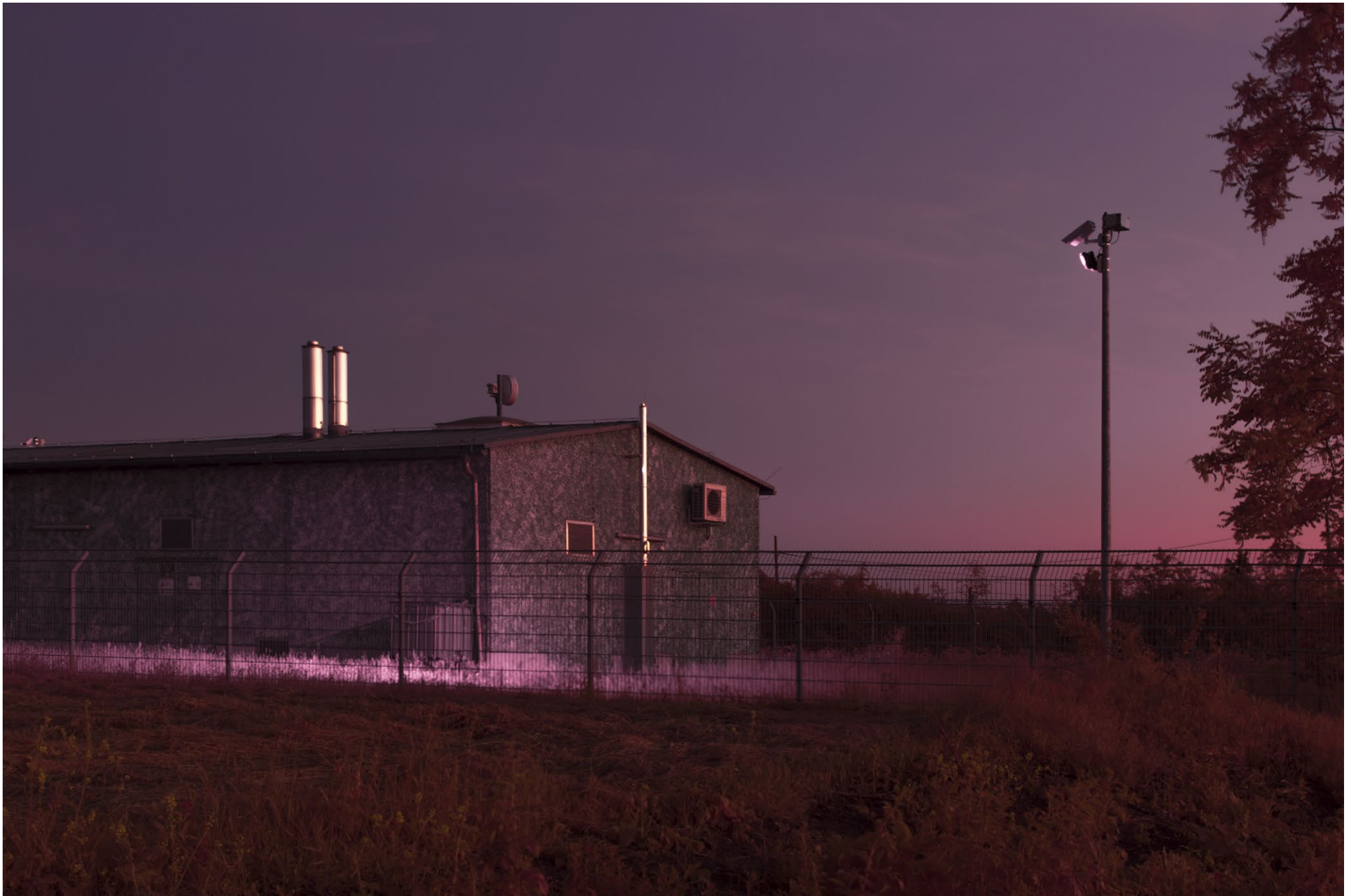
Gasverteilerstation Ringelberg, Erfurt (Infrarot)
